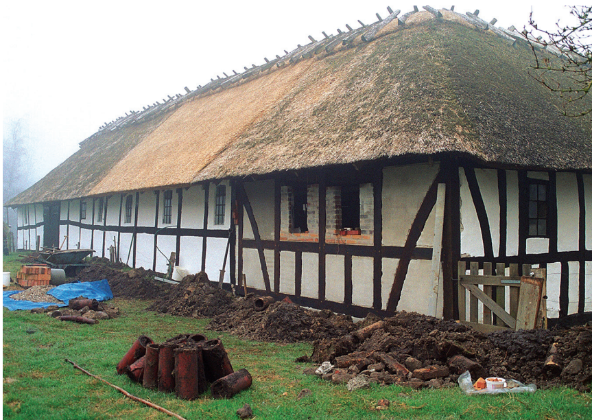
I 2010 foretog vi det første større indgreb i bindingsværk på gården. Portlængens gavl mod syd blev udskiftet med helt nyt tømmer. (Se side 17)
