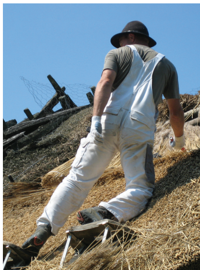
Et ønske om en ny stue på 1. salen nødvendiggjorde tækkearbejde med ny kvist. Undertiden fremskyndes fornyelse af stråtag på grund af andre forhold end et helt nedslidt tag.
