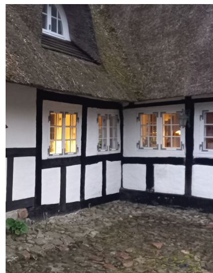
Porthullet mod vest blev lukket, da det gav lidt mere boligareal. Bemærk 'springet' fra det gamle bindingsværk til det nye. Det afslører, at vi har lavet et indgreb.
