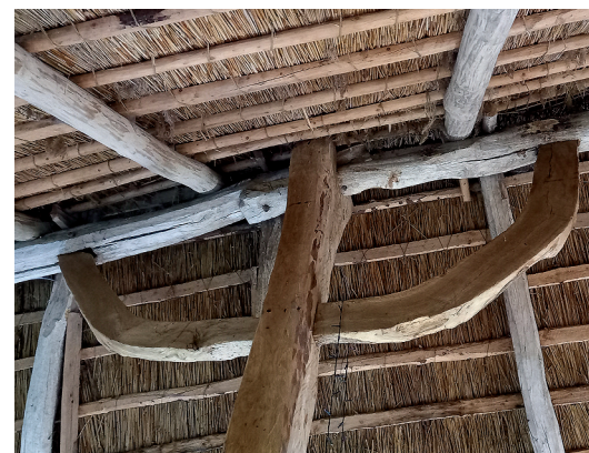
Sulerne bærer den vandretliggende ås, hvorpå spærerne er fastgjort.
