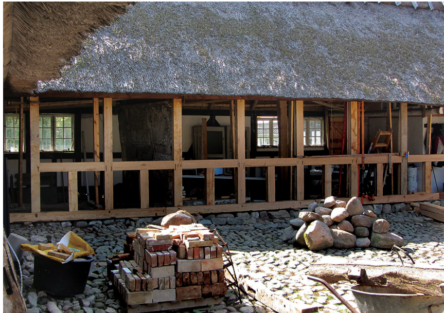
Bindingsværksbyggeri er 'Lego' eller 'Techno' - og særdeles klimavenligt.
