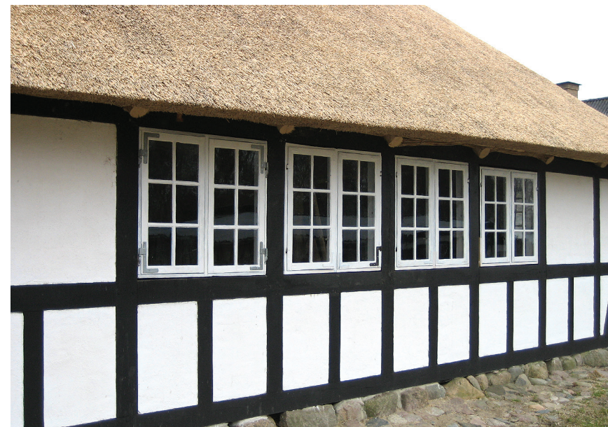
Spritnyt bindingsværk skaber et lidt forsk udtryk, men vi glæder os over ny facade med begrænset behov for vedligeholdelse.
