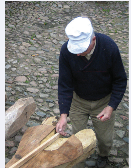
Tvejen, som åsen skal hvile i, tilpasses med skabelon fra den gamle sule (t.v.)
