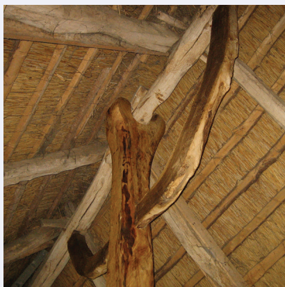
De gamle skråbånd fra den nye sule til åsen blev genbrugt efter lidt tilvirkning.
