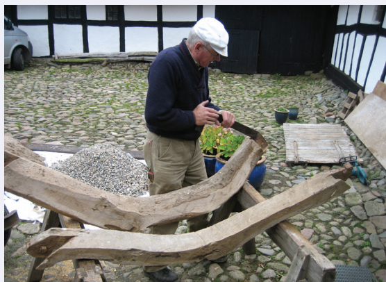
De gamle skråbånd fra den nye sule til åsen blev genbrugt efter lidt tilvirkning.
