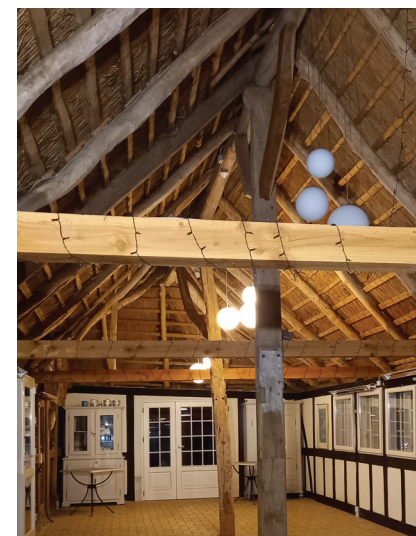
Sulerne (”søjlerne”) står ned midt i bygningen.
