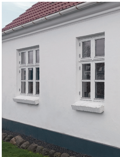
Såkaldte "bondehusvinduer" blev moderne i 1970'erne. De var energibesparende med termoglas. Og staten gav tilskud til energibesparende foranstaltninger i boliger. Det betød, at rigtig mange småsprossede, kittede vinduer blev kasseret til fordel for disse nye "bondehusvinduer" Fotoet er taget i Vissenbjerg by, med ejers tilladelse.
