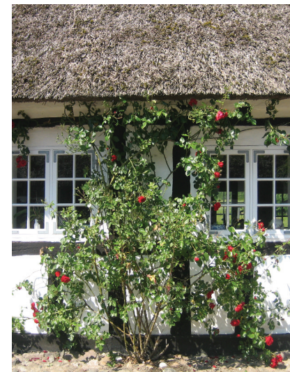
Vores valg af småsprossede, kittede vinduer har vi ikke et sekund fortrudt - heller ikke selvom en løsning med 'moderne' bondehusvinduer med tre termoruder i hvert fag havde været tre gange billigere.
